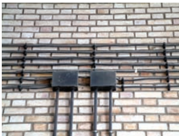
شکل ۲۸-۲- کابل‌کشی روی دیوار
