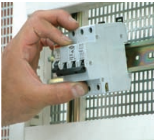
طرز قرارگیری فیوز روی ریل
